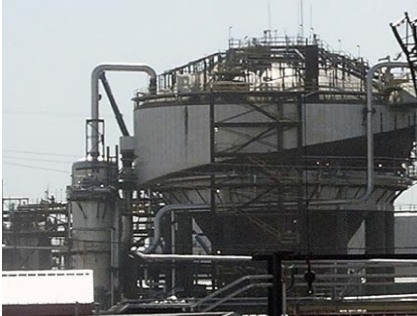
Initial sand:oil separator
